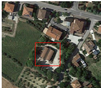
Piazzale per lo stoccaggio provvisorio delle macerie.
